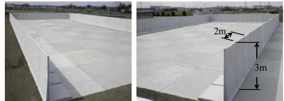
写真-1 大型管理ヤードの構築例
