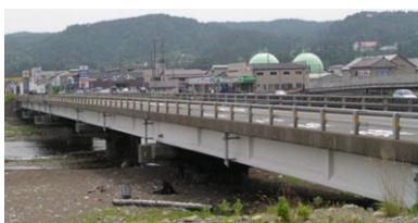
写真-1 対象橋梁の全景
