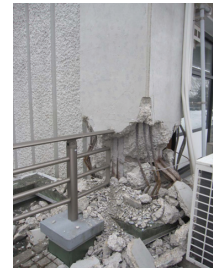
写真-1 柱の被害写真
