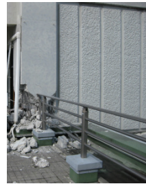
写真-1 柱の被害写真
