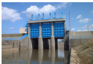
写真-1 樋門構造物 1)
