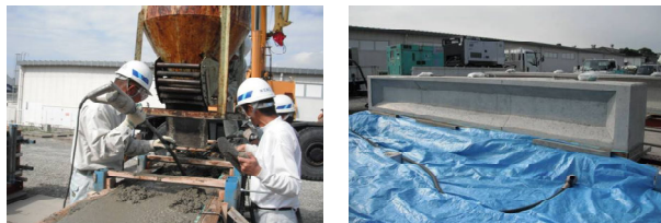
(a) 生コン打設
