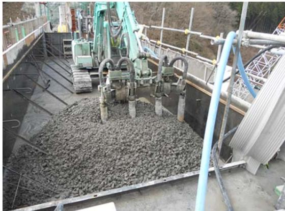
図-2 締固め状況
