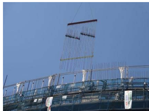
写真-1 専用治具による鉛直鉄筋の吊上げ状況
