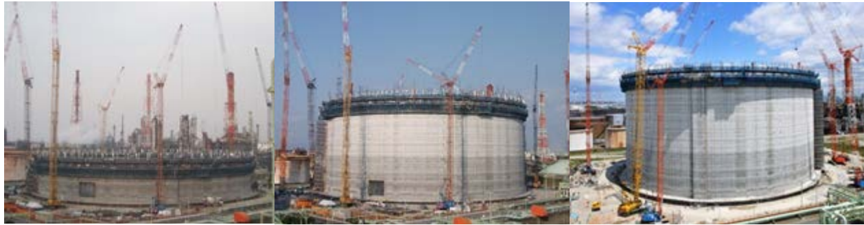
写真-6 スリップフォーム工法によるPC防液堤の構築状況（左：5日目，中：15日目，右：20日目）
