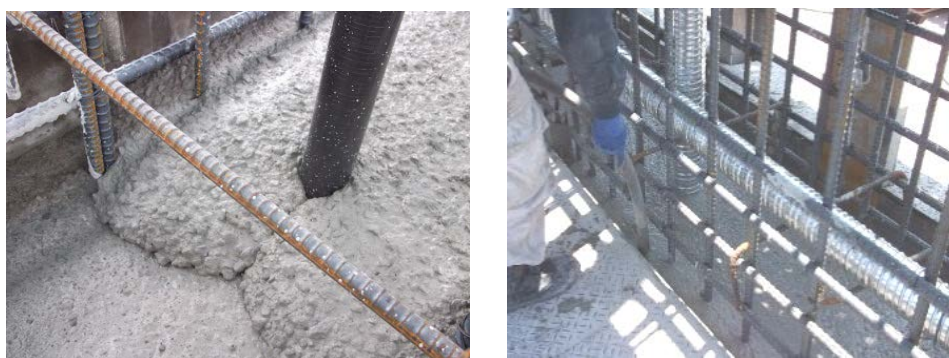
写真-5 コンクリートの流動および締固め状況
