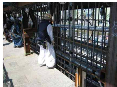
写真-2 水平鉄筋の設置状況
