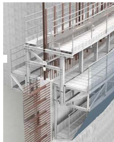
図-2 スリップフォーム装置のイメージ
