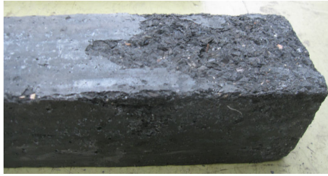
写真-5 凍結融解試験後の損傷状況 (転炉系スラグ)
