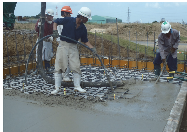
写真-1 コンクリートの打込み作業状況
