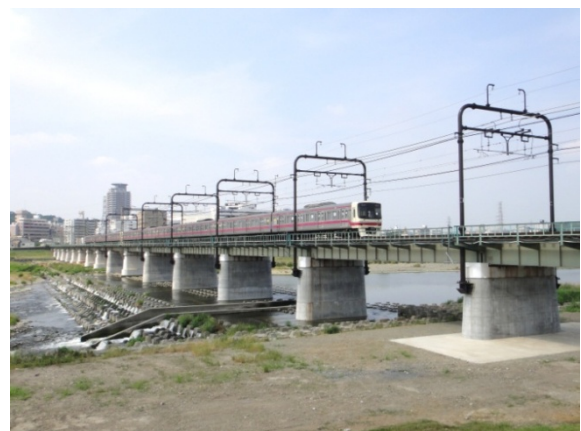
写真-1 河川を渡る橋梁
