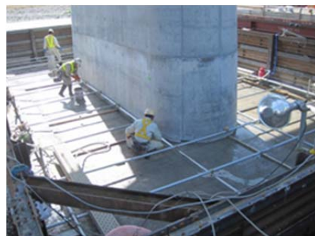
写真-5 橋梁基礎コンクリート天端(施工箇所)
