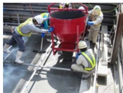
写真-6 打込み状況
