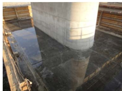
写真-7 養生完了時の状況
