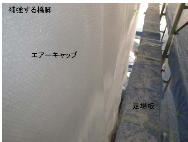
写真-1 エアークャップによる封緘養生の一例
