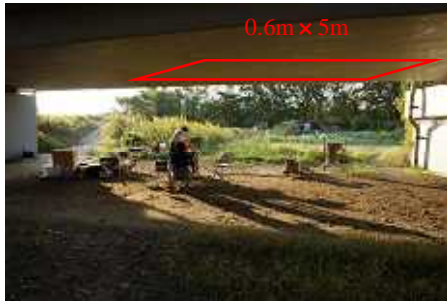
写真-3 音響探査を実施した RC 床版
