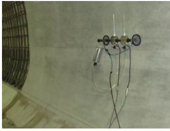
図-15 トンネルの90度の位置での測定状況
