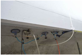
図-16 張出し床版下面での測定状況
