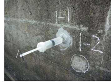
写真－1 現地試験を実施した開水路の概況と凍害の発生状況ならびにシランオリゴマーの注入状況
