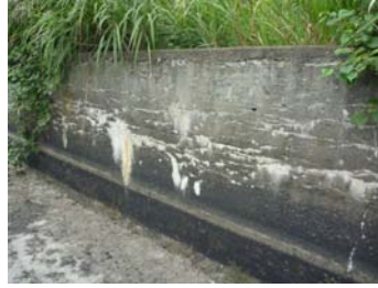
写真－1 現地試験を実施した開水路の概況と凍害の発生状況ならびにシランオリゴマーの注入状況
