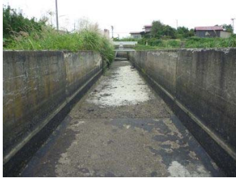
写真－1 現地試験を実施した開水路の概況と凍害の発生状況ならびにシランオリゴマーの注入状況
