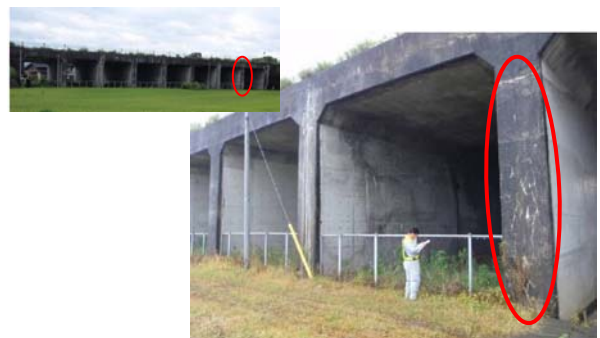
図-1 カルバート構造と検討対象部材
