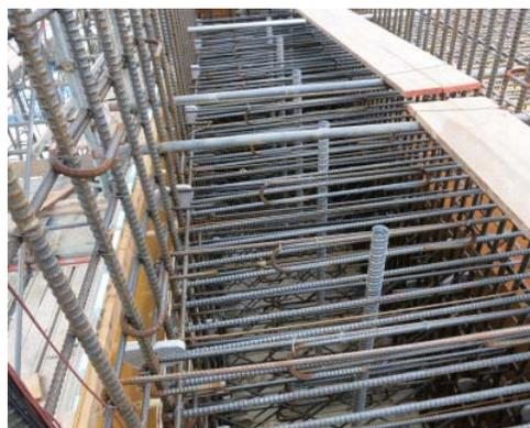
写真-3 クーリングパイプ設置状況
