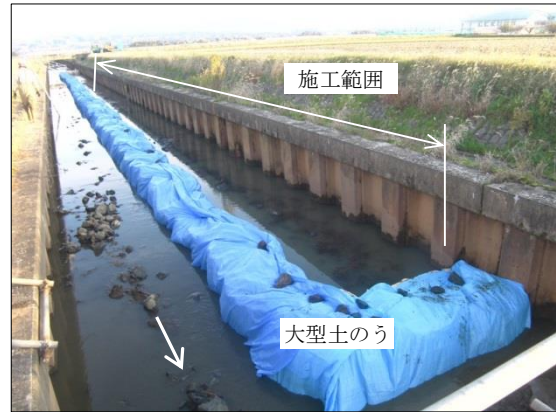
写真-5 Case 1 大型土のうによる流水処理
