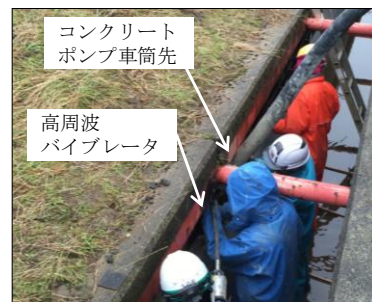
写真-8 水路内でのコンクリート打設作業
