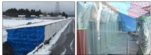
(A) 仮囲いによる養生 (B) 仮囲い内での施工状況
