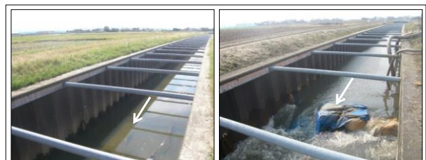
平常時の実測流量0.3m 3 /s 降雨時の実測流量3.1m 3 /s (日雨量20mm)
