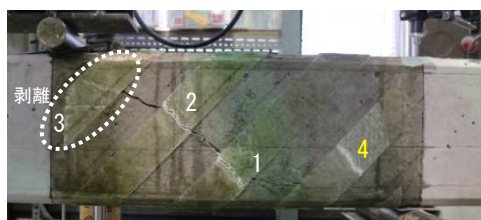
写真-8 No. 8 (50% 45度) せん断破壊状況
