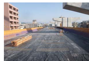
写真-1 高架橋床版打設工事中 (東側を臨む)
