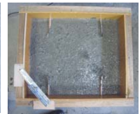
繊維コンクリート部分打ち工法
