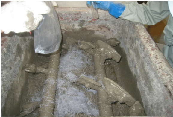
写真-1 繊維と増粘剤一体型高性能 AE 減水剤の投入
