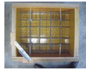
繊維シート埋込み工法
