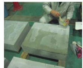
樹脂の塗付け工法
