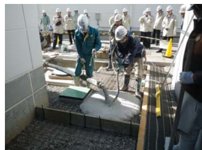
図-5 環境配慮コンクリートの打込み状況
