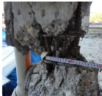
(a) 柱全体 (b) 柱脚局部 写真-3 2階柱被害の詳細
