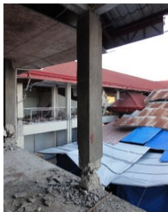
(a) 柱全体 (b) 柱脚局部 写真-3 2階柱被害の詳細
