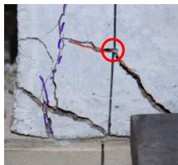
写真-3 試験体引張側脚部
