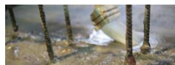
写真-1 打継面処理の様子
