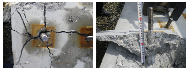
図-9 試験後の破壊性状(8-1, C12-1)
