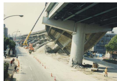
写真-2 阪神高速神戸線の兵庫県深江地域の被災状況
