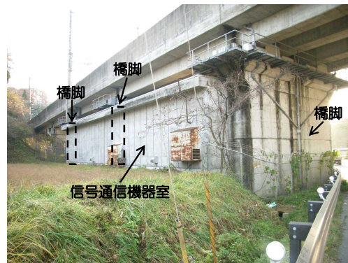
写真-1 高架下が機器室に利用されている橋脚
