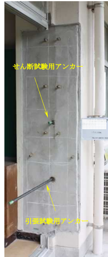
写真-1 アンカーの打設状況
