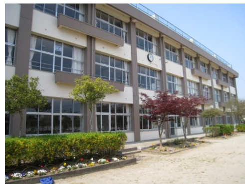
写真-1 建物外観 (南側)
