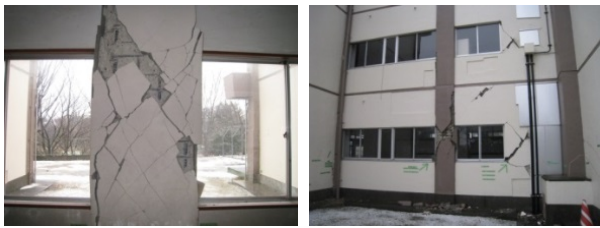
(a) 柱のせん断破壊 (b) 柱のせん断破壊 (写真(a)の外側からの様子)
