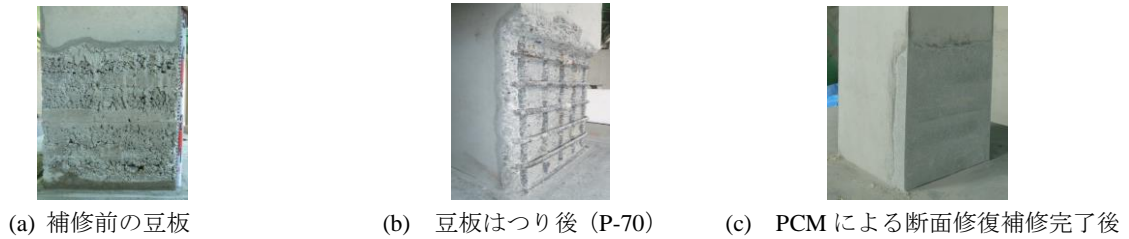
写真-1 従来補修試験体の補修状況
