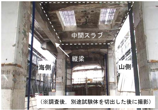
(a) 対象部材の概観
