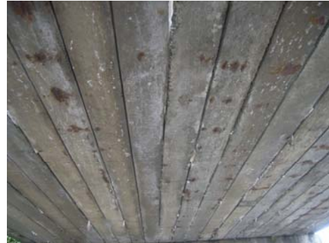
写真-4 B橋の外観状況
