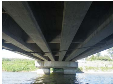
写真-3 A橋の外観状況
