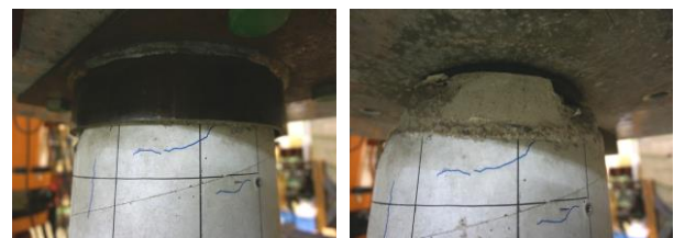
(a) 鋼管取り外し前 (b) 鋼管取り外し後 写真一 2 試験体 No. 3 実験後杭頭部写真
