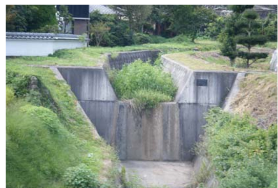
写真-1 床固工外観
