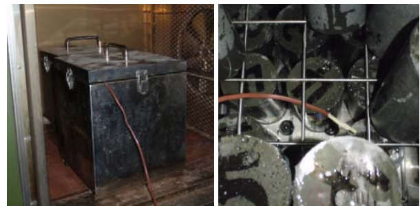
写真-3 蒸気養生の状況
