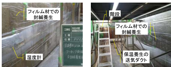
写真-4 フーチングでの封緘養生の実施状況
