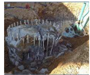
写真 - 18 かぶり部分・ 斫り取り(杭 No.24)
