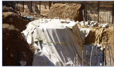
写真 - 15 防爆養生(杭 No.24)
