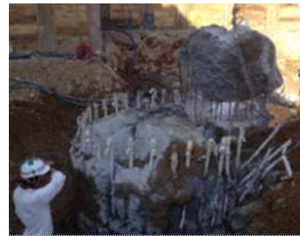
写真 - 19 破砕片揚重(杭 No.24)
