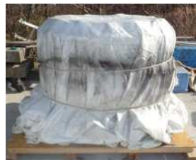
写真 - 22 防爆養生
