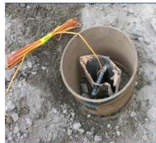
写真 - 12 抜け出し防止 ピンとモルタル用型枠材
