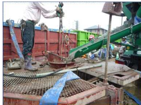
写真-7 杭コンクリート打設
