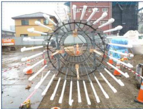
写真-2 装薬ホルダー設置例
