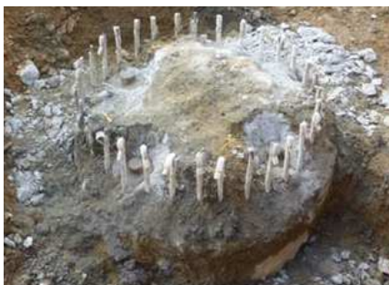
写真 - 14 破砕前状態(杭 No.24)
