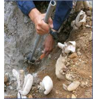
写真 - 11 タンピング (粘土挿入後)
