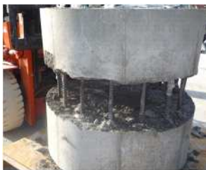
写真 - 23 破砕後揚重
