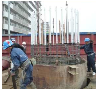
写真-5 杭鉄筋建込み
