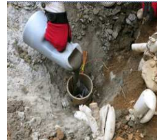
写真 - 13 超速硬無収縮モルタルの充填
