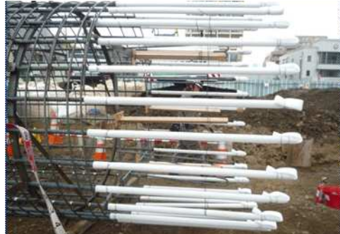
写真-4 杭主筋付着切り材(エスレンボイド)
