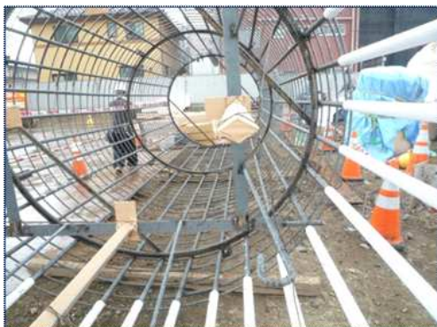
写真-3 装薬ホルダー設置方法(近接)
