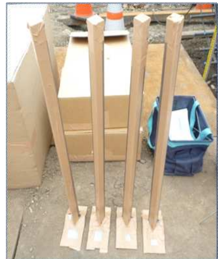
写真-1 装薬ホルダー (水平・鉛直同時破断方式)
