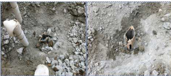
写真 - 9 装薬ホルダーの状況 (杭 No.13)
