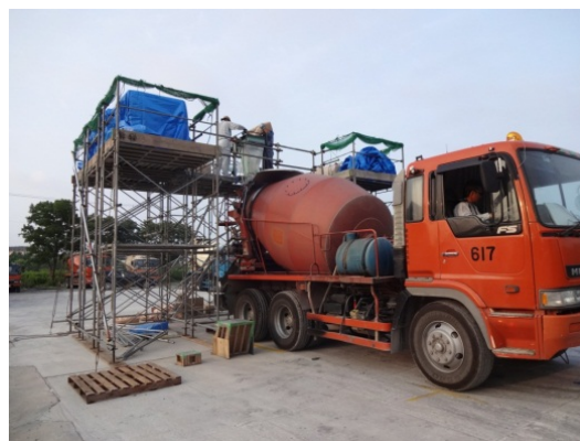
写真-1 鋼繊維投入場の外観
