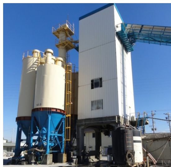
写真-2 製造工場の外観
