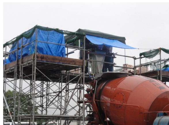
写真－4 鋼繊維投入時の雨天対策の状況
