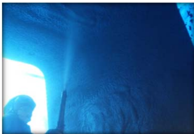
写真-4 吹付け状況
