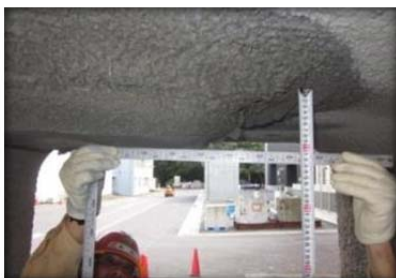
写真-5 天井面吹付け厚さ検尺状況
