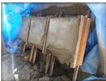
写真-6 吹付け試験体表面仕上げ状況
