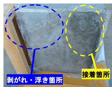
写真-7 脱枠時フィルム状況 (ケース 3)
