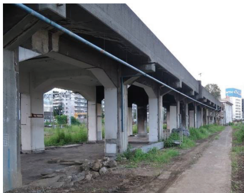
写真-1 高架橋の外観
