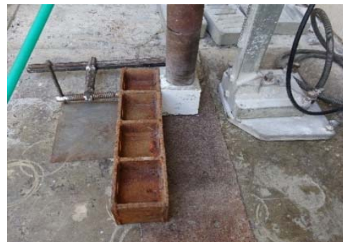
写真-2 コア抜きの写真
