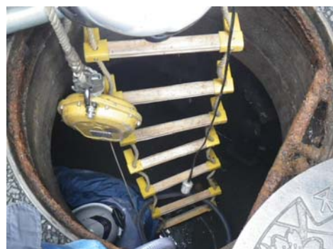
写真-1 マンホール内における作業の様子
