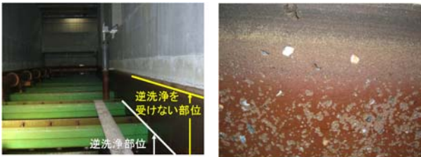
(a) 全体図 (b) 逆洗浄を受けない部位 図-3 A 浄水場の後段ろ過池の外観写真
