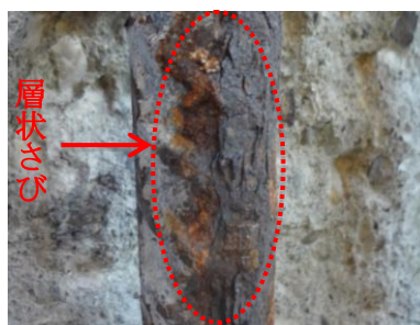
写真-3 分析試料5の層状さび
