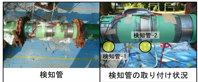
写真-1 検知管の取り付け状況
