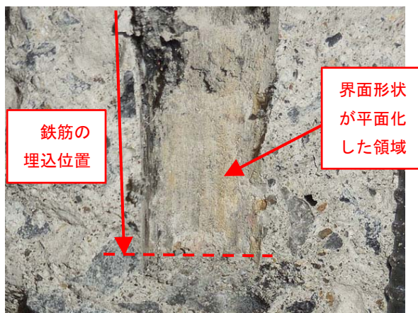
図-6 引抜き破壊後の内部の様子(S9)
