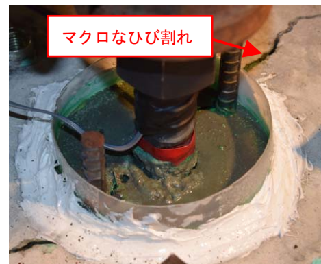
図-12 マクロなひび割れを伴う引抜き破壊(S14)
