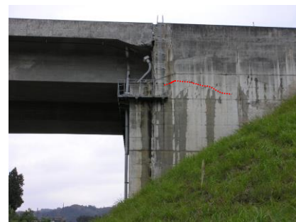
(赤実線は押し抜きせん断によるひび割れ位置)
