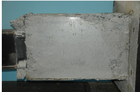
写真-1 接合鋼管内コンクリートの破壊状況 (試験体 B3, 実験後)
