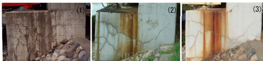
写真-1 表面被覆の ASR による再損傷の事例 1)
