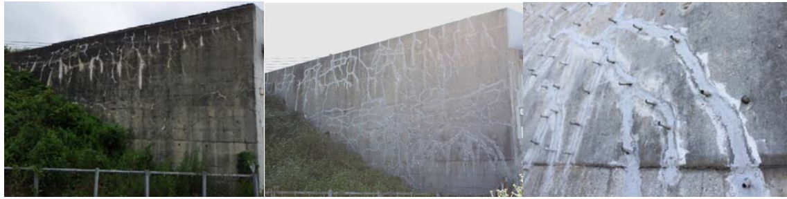
(1)補修前 (2)補修後 (3)ひび割れ充填工と導水工 写真-7 シラン系表面含浸材とひび割れ充填工による補修
