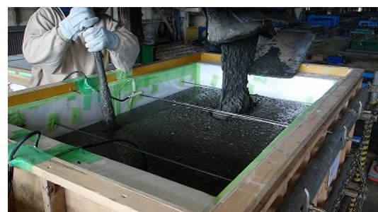
写真-1 コンクリート打ち込み状況 (W/B=12%, 冬期)
