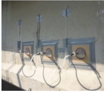
写真-3 A橋の透水性試験実施状況
